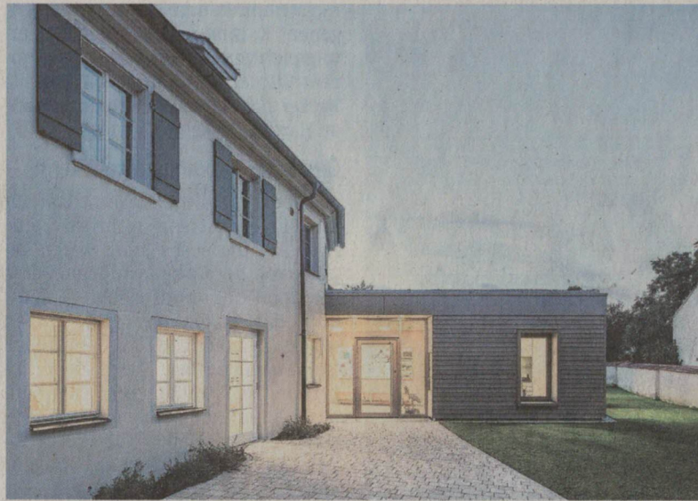
Die im vergangenen Jahr fertig sanierte und um einen Anbau ergänzte Kita Storchennest kann am Samstag besichtigt werden. Foto: Maximilian Gottwald (Herrsching)
