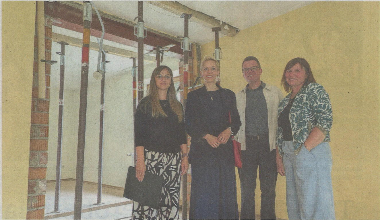
Die Umbaumaßnahmen laufen: Oberbürgermeisterin Eva Reichstadt und Pfarrer Alexander Reichelt mit Josefine Raab (Stadtbauamt, li.) und Sieglinde Bleicher (Leitung Montessori-Kindergarten). Foto: Barbara Struller
