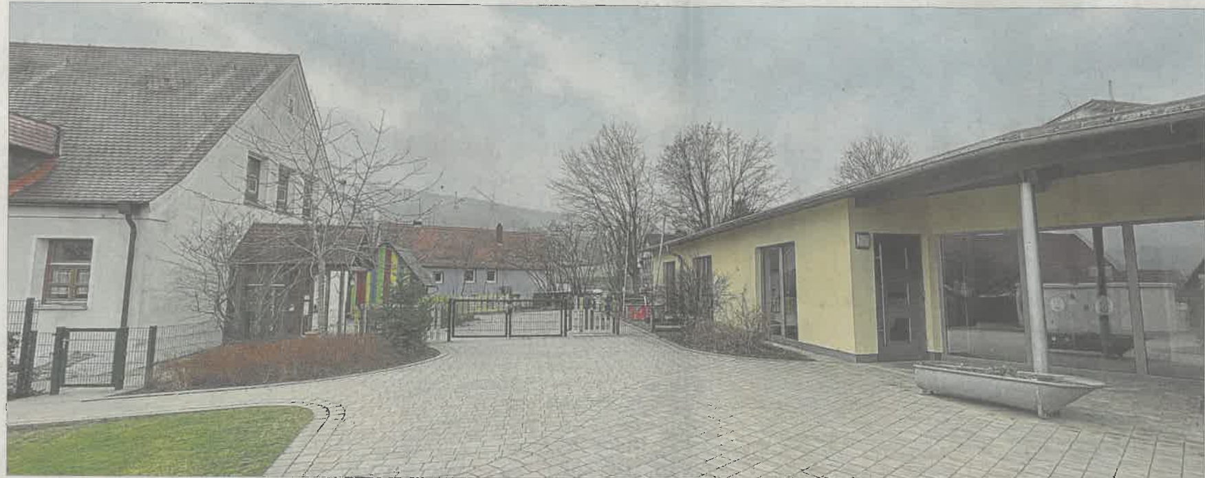
Die Thalmässinger Liste wollte einen Bedarfsplan für die Gebäude der Kinderbetreuung in Thalmässing. Die Mühlbachkrippe, Haus eins, von 2013 (rechts) steht zwar leer, ist aber quasi ein Neubau. Der Arche-Noah-Kindergarten (links) ist inzwischen saniert. Bleibt also nur die Sanierung im Regenbogen-Kindergarten. Foto: Viola De Geare
