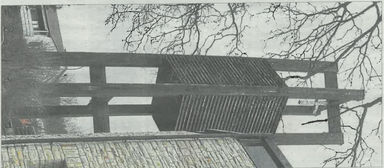
Der Kirchturm in reiner Holzbauweise , wie er mehr als 50 Jahre neben der Apostelkirche gestanden hat, ist nicht mehr. Noch verbringt es das Gerüst einigermassen, doch der Bau hat stellenweise ein Stahlkorsett bekommen, das ihn stabilisiert. Pfarrer Rudolf Hackner, der lange für die Sanierung gekämpft hat, findet die gefundene Lösung gelungen.
