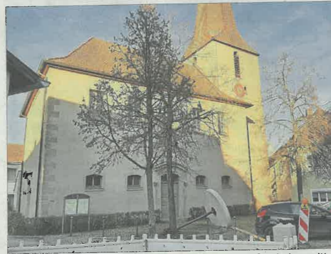
Auch wenn die Sanierung von St. Marien aus Städtebaumitteln finanziell unterstützt wird, Bauherrin ist die Kirche. Foto: Karch
