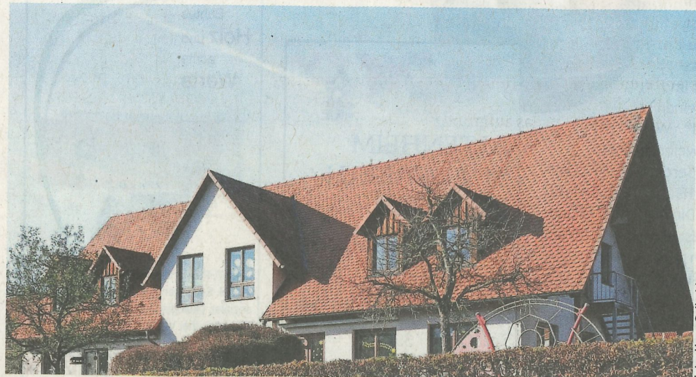
Der evangelische Kindergarten in Höttingen, das sogenannte Spatzennest, muss im kommenden Jahr umfassend saniert werden. Unter anderem stehen energetische Sanierungen an.
