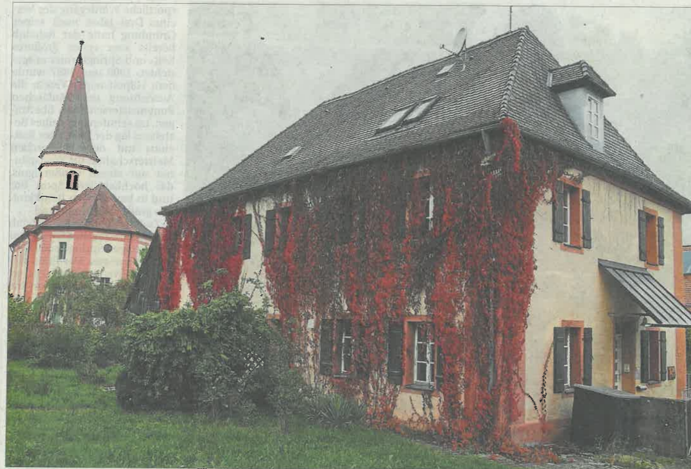
Das derzeit leerstehende Pfarrhaus soll wieder bewohnt werden: Nachdem die Pfarrfamilie Lorenz Ende 2018 die Eysöldener Gemeinde nach 20 Jahren verlassen hatte, entwickelten sich die Planungen zur Sanierung des denkmalgeschützten Gebäudes zu einer Hängepartie. Doch inzwischen ist klar: Im kommenden Jahr erfolgt eine umfassende Ertüchtigung.
