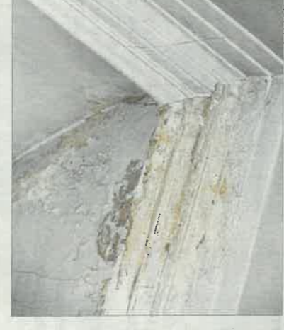
Der imposante Dachstuhl der Kirche weist große Feuchtigkeitsschäden auf. Auch an der Fassade hat der Zahn der Zeit seine Spuren hinterlassen. Die eindringende Feuchtigkeit hat den Putz an der Decke beschädigt (Bild unten rechts).
